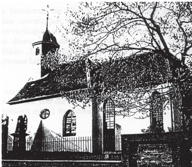
Die Kirche im Zustand bis 1965
