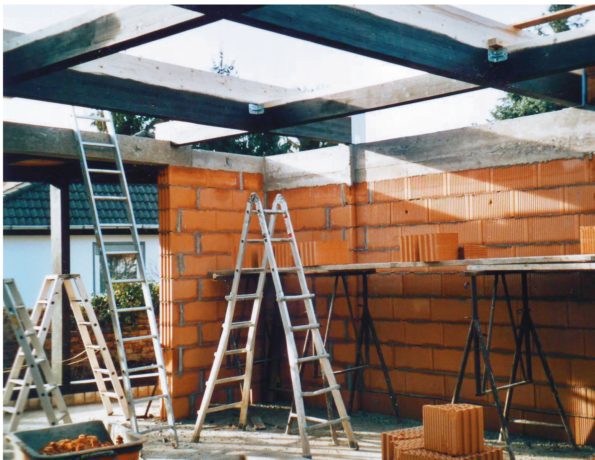
Montage des Dachtragwerkes am 21.3.2005
