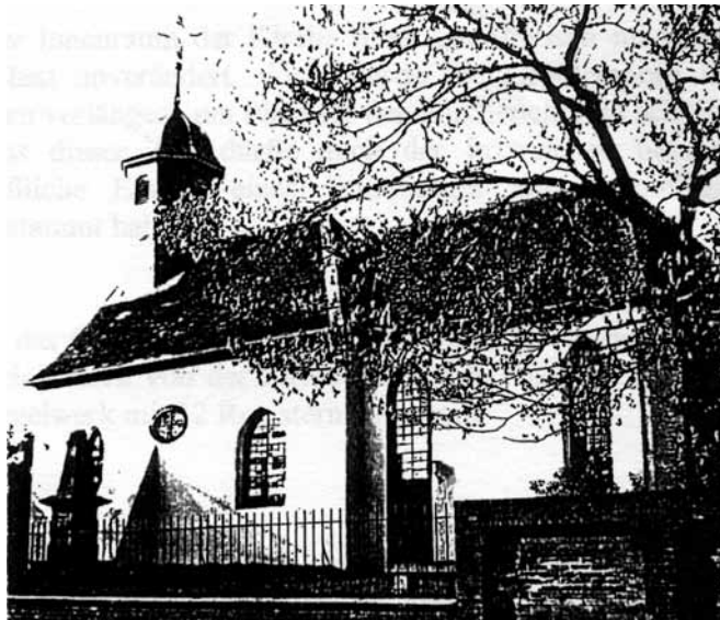
Die Kirche im Zustand bis 1965
