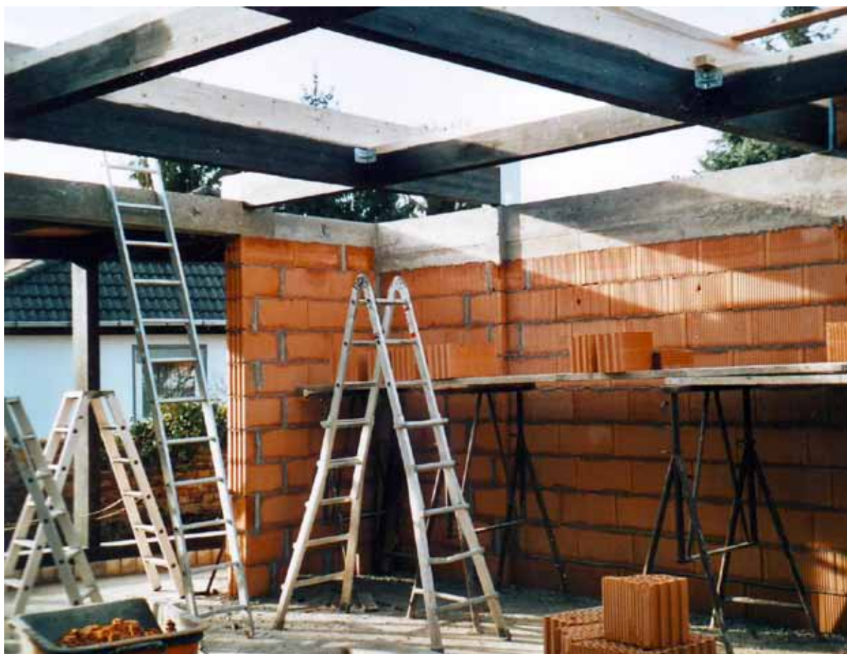
Montage des Dachtragwerkes am 21.3.2005
